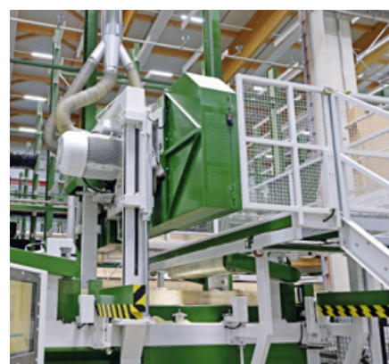
Wird das Leimholz nicht aufgetrennt, bleibt die TBS 1200 oben in Parkposition – das BSH fährt unten durch. Beim Sägeblattwechsel wird beim Podest ein Sicherheitsboden ausgefahren, wodurch die Produktion ungestört weiterläuft
