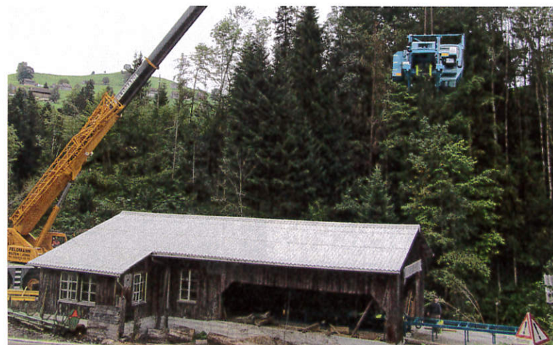
Kommt eine Blockbandsäge geflogen: Die Montage mit einem Kran.
