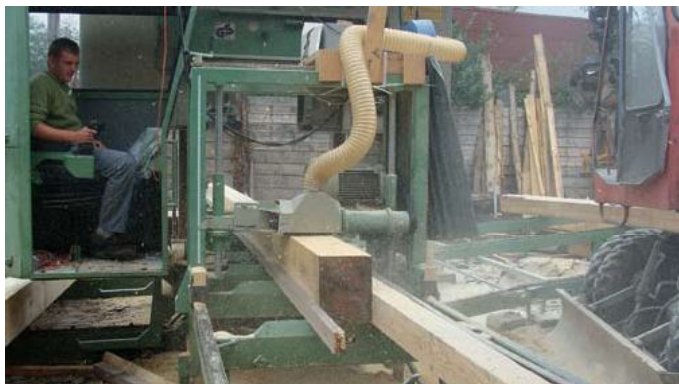
Sterujący pracą maszyny operator siedzi w kabinie poruszającej się wraz z piłą wzdłuż torowiska.
